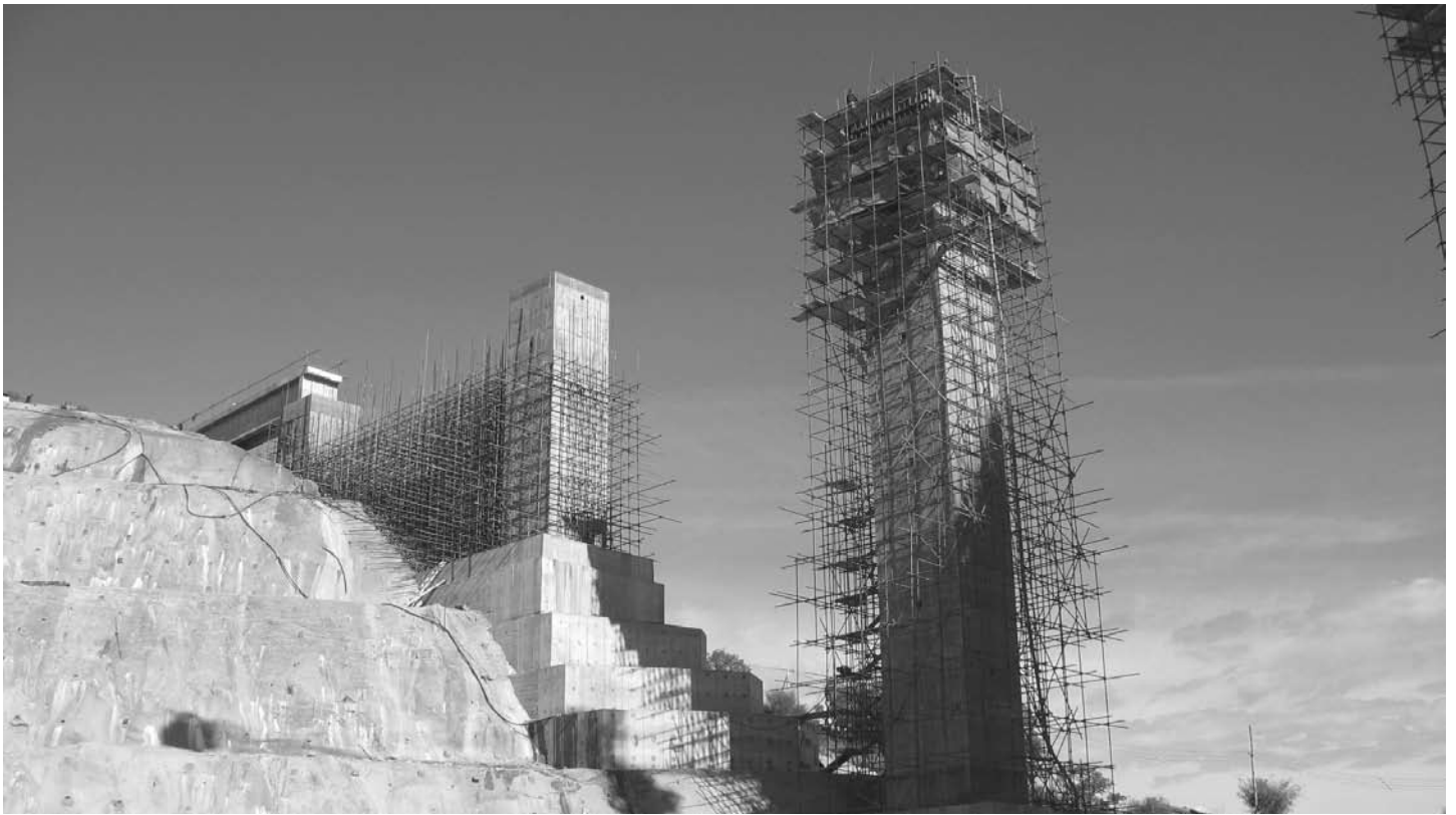
Barrage de Kébir (Tunisie) – Photo : SOGREAH
