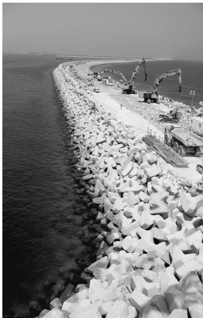
Port de Ras Laffan (Qatar) : mise en place des protections ACCROPODE™ des digues – Photo : SOGREAH
