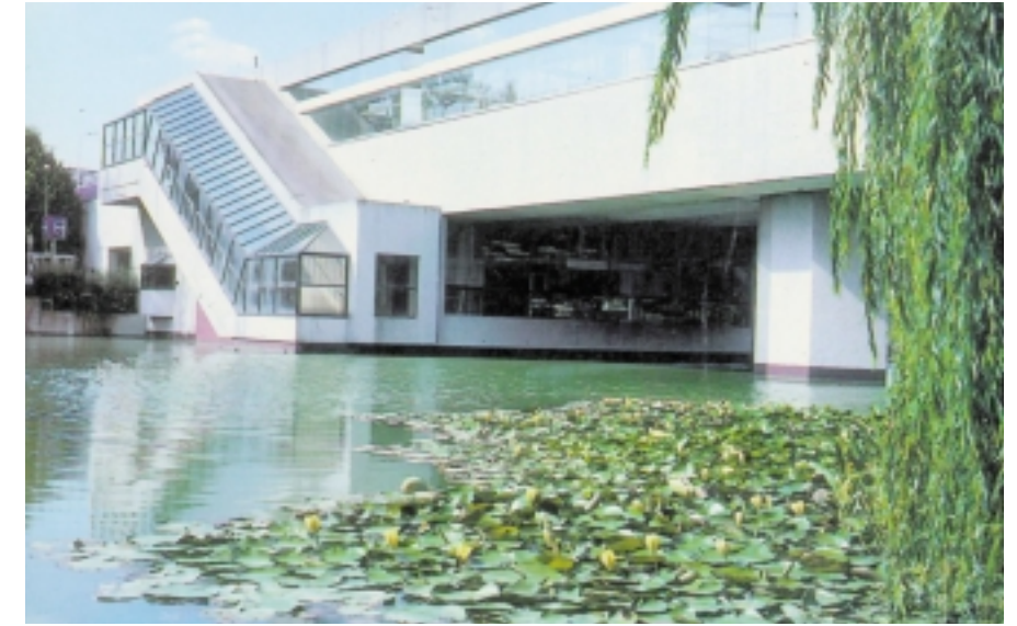
Bassin de rétention d'eaux pluviales, région lyonnaise.
